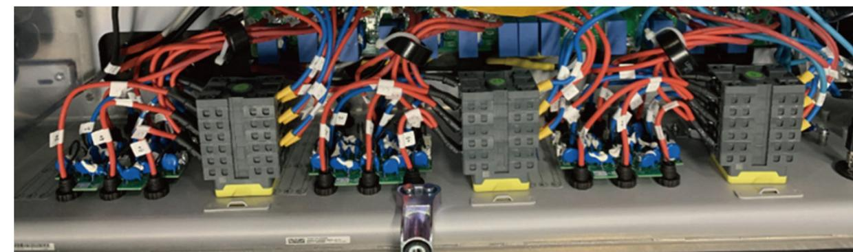
图 23: 传统方案逆变器的直流端子接线方式
